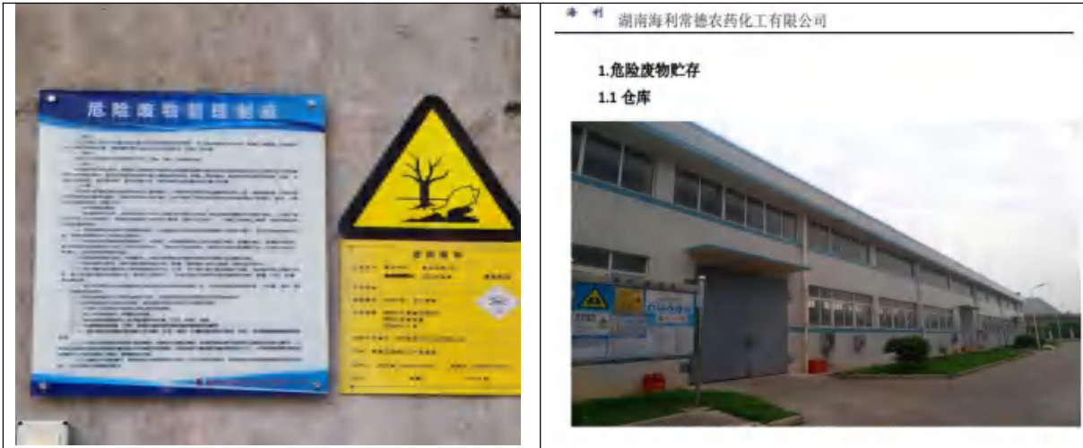
危险废弃物仓库
