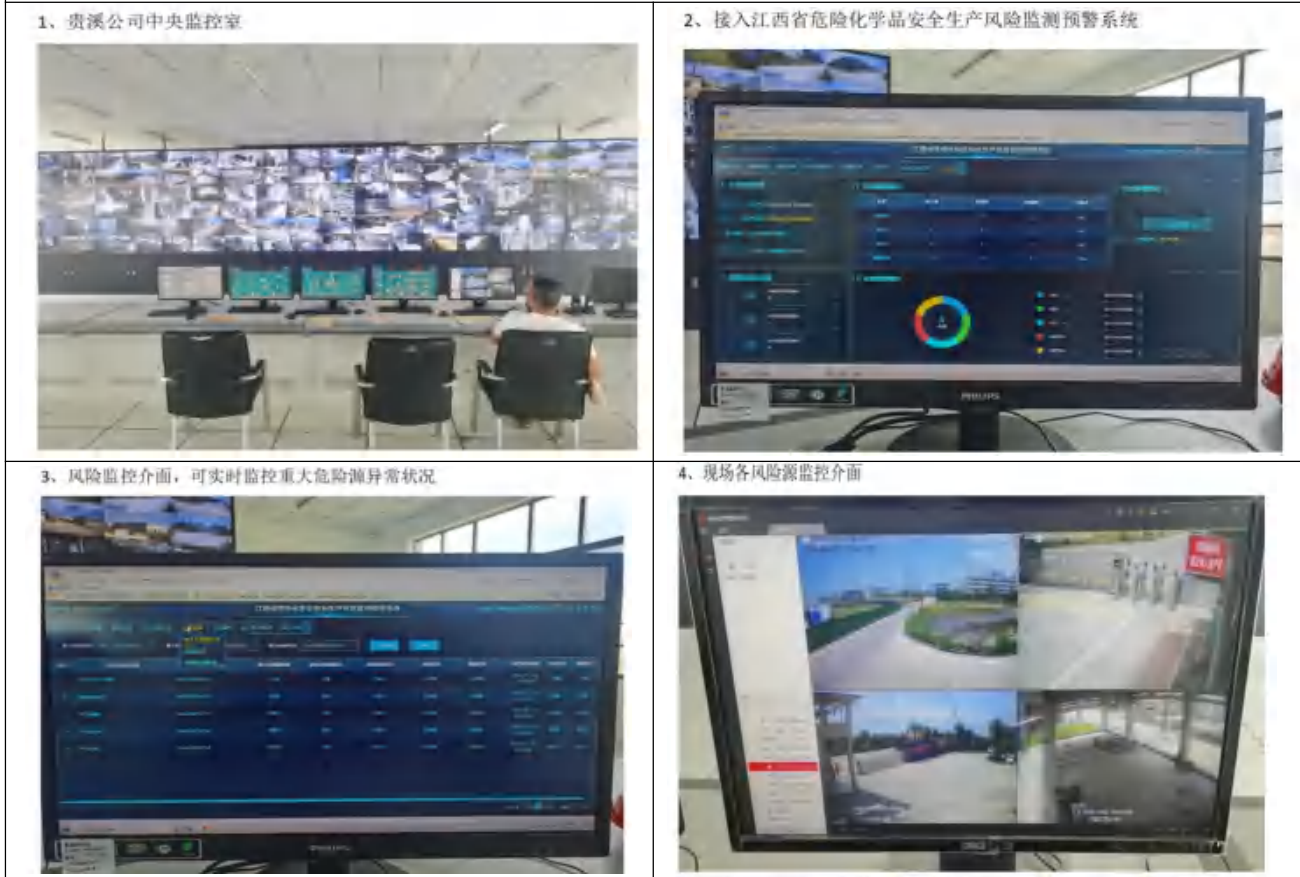
贵溪公司中央控制室危险化学品安全生产风险监控系统
