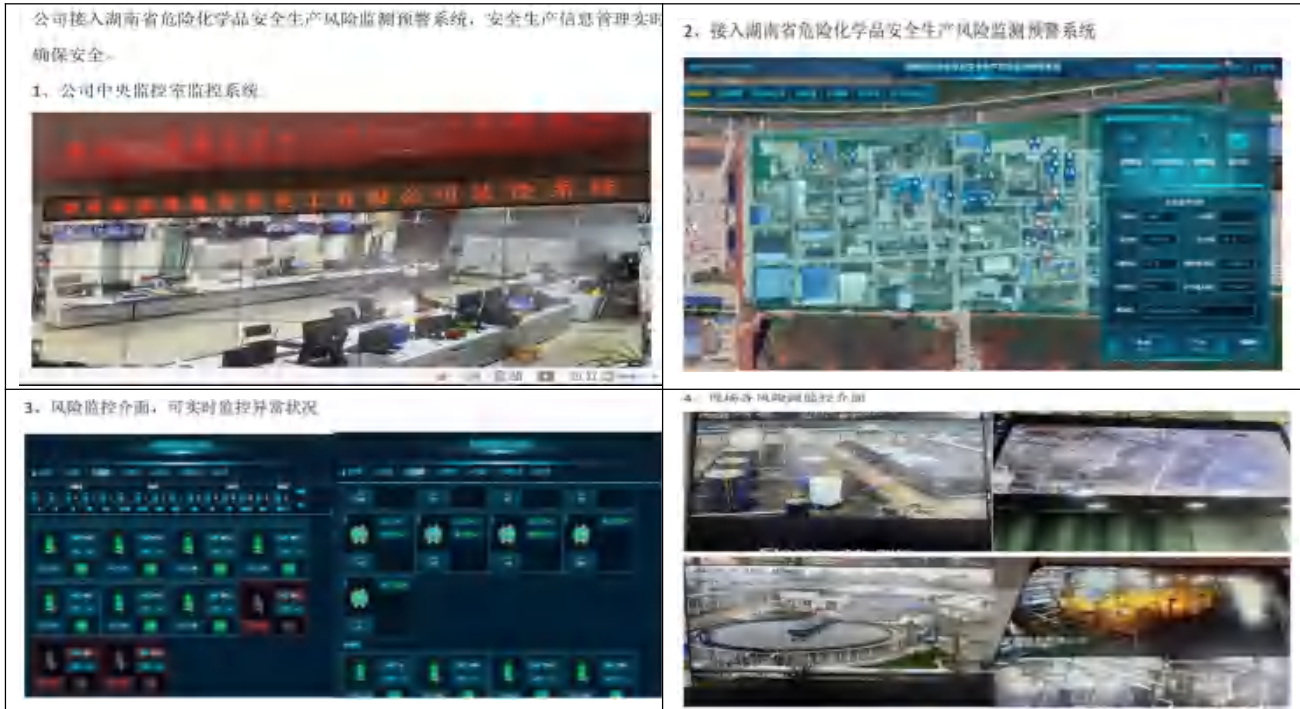
常德公司中央控制室危险化学品安全生产风险监控系统
